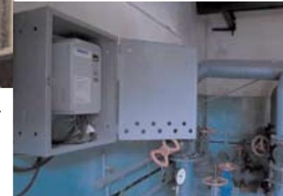
К таким решениям, безусловно, относится установка частотно-регулируемых приводов на асинхронные двигатели мощностью от 0,75 кВт до 800кВт и современных устройств плавного пуска (контроллеров-оптимизаторов).
